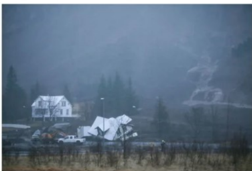
Aurskríður verða vanandi vandaná með veðurriðkunum í framtíðinni. Ólla skipir hvernig viðhöf til þess verða á breytingum stað og til þess þarf að sjá höldunarmáttina með góðum fyrirvæni. Mynd: GG
